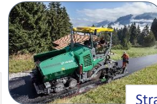
Straßenbau Source: Vögele
